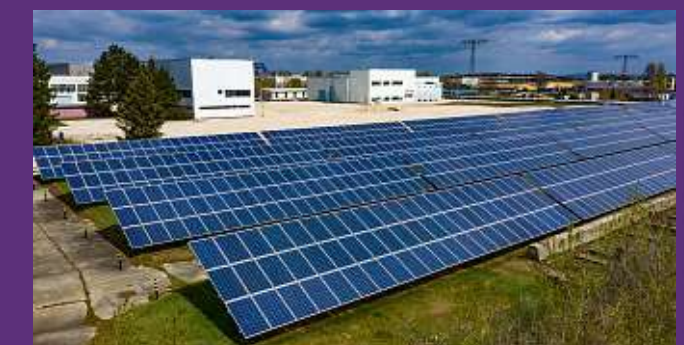
Diese PV-Anlage in Bautzen betreibt Sachsen-Energie. Das Unternehmen verhandelt in der Lausitz mit Grundstückseigentümern.
