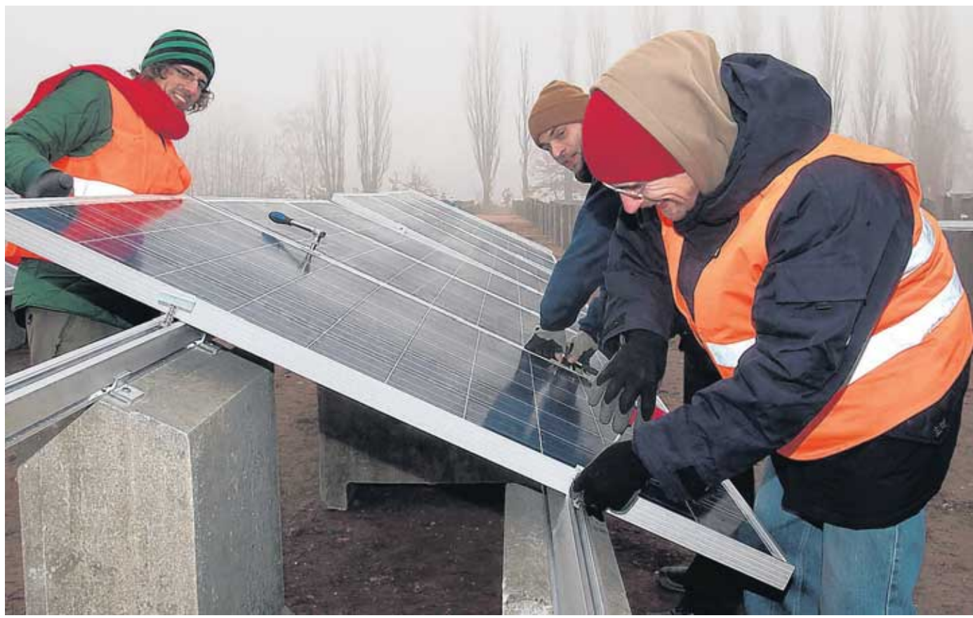
Mit Hochdruck wird an der Montage der Module gearbeitet.
